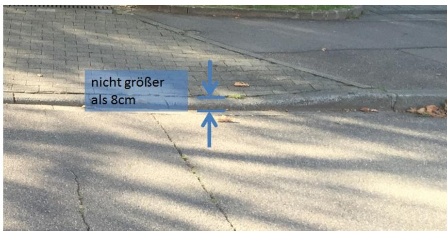
Abbildung 6 - Bordsteinkanten dürfen höchstens 8 cm hoch ausgeführt werden
