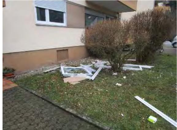
Durch die Explosion wurden mehrere Fenster aus ihren Verankerungen gerissen. Trümmerteile beschädigten Nachbargebäude und abgestellte Fahrzeuge, auf der Straße verteilt lagen Glassplitter, es brannte nicht.
