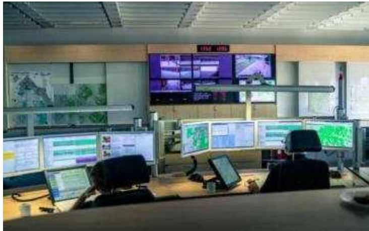
Die Integrierte Leitstelle.
